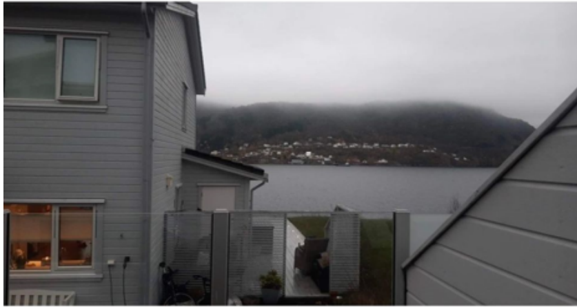
Eksisterende situasjon sett frå nabo – vedlagt nabomerknad til søknad
