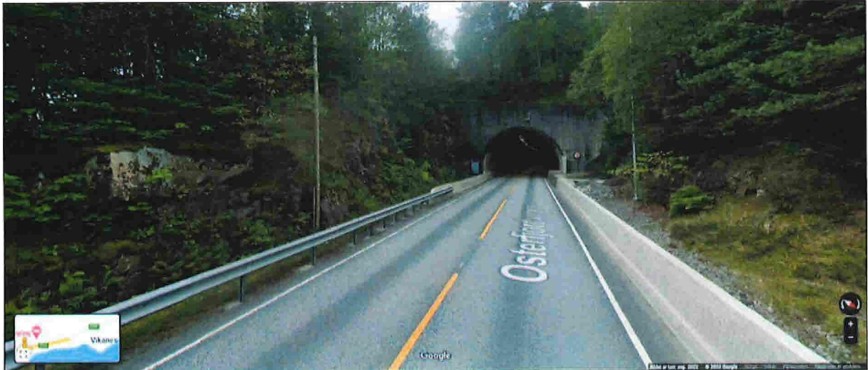
Figur 16: Tunnel skjæring til Midtnestunnelen, sørvest i tiltaksområdet, viser fjell i dagen. Kilde: google.no/maps.
