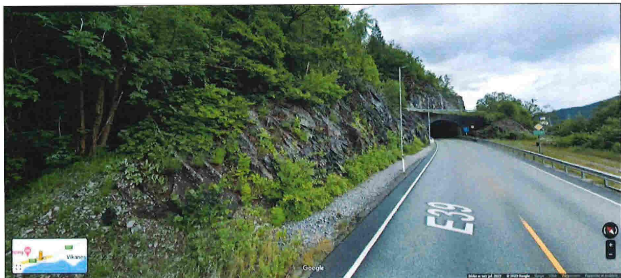
Figur 17: Tunnel skjæring til Vikanestunnelen, sørøst i tiltaksområdet, viser fjell i dagen. Kilde: google.no/maps.
