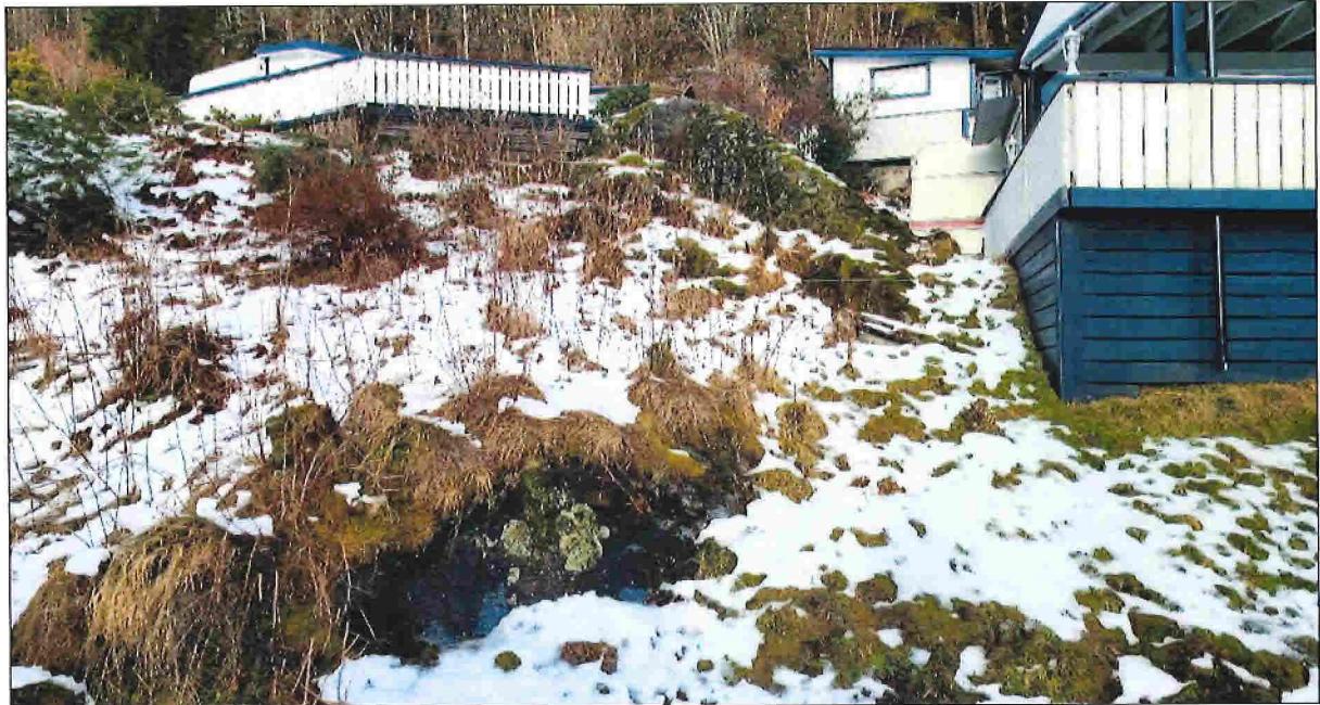
Figur 11: Bildet viser fjell i dagen i tiltaksområdet (Foto: SGC).
