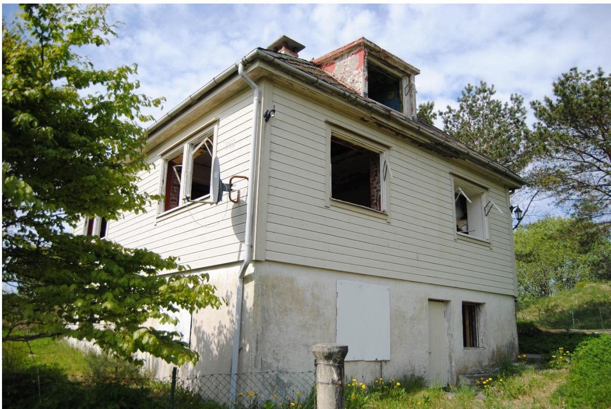
Fasader mot sør og øst.
