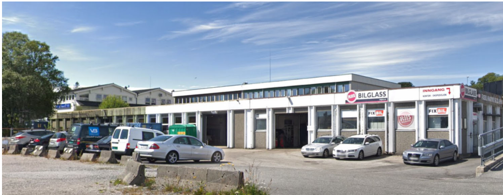
Bruvegen 3, fasade mot sør
