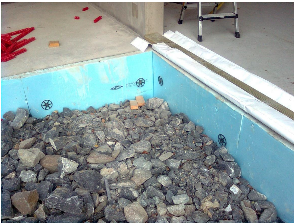
Figur 7 Eksempelbilde: XPS-plater brukt langsmed gulv på grunn.
