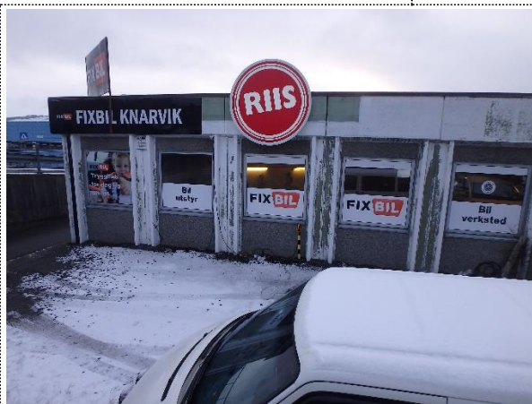
Østre del av nordfasaden
