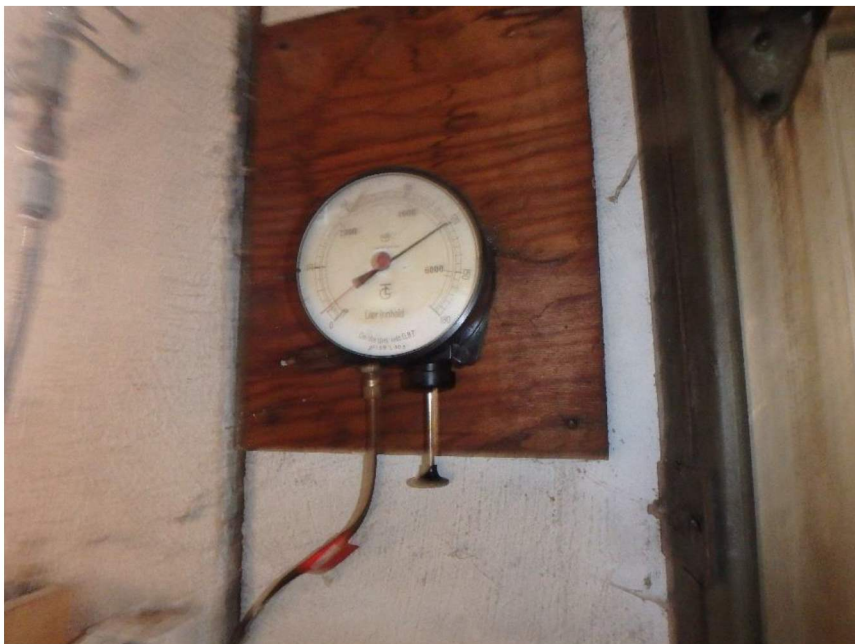
Figur 1 Måleinstrumentet på veggen i sprinklerverkstedet viste at det på befaringstidspunktet (januar 2023) var mye olje igjen på oljetanken som er nedgravd ved sydfasaden.
