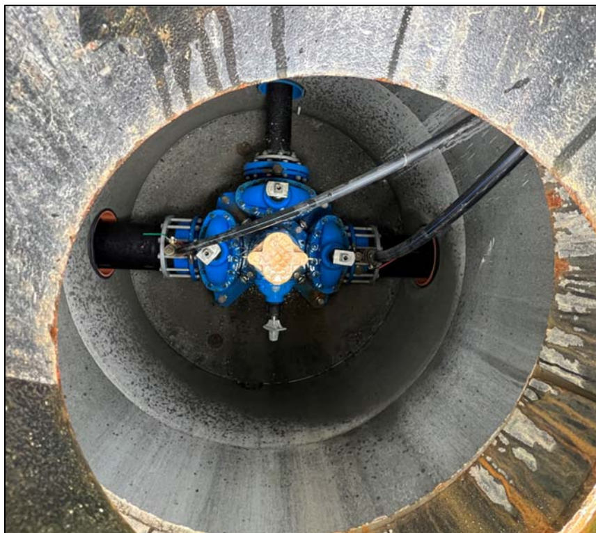
Bilde 1 - Eksisterende brannvannskum SID 44340
