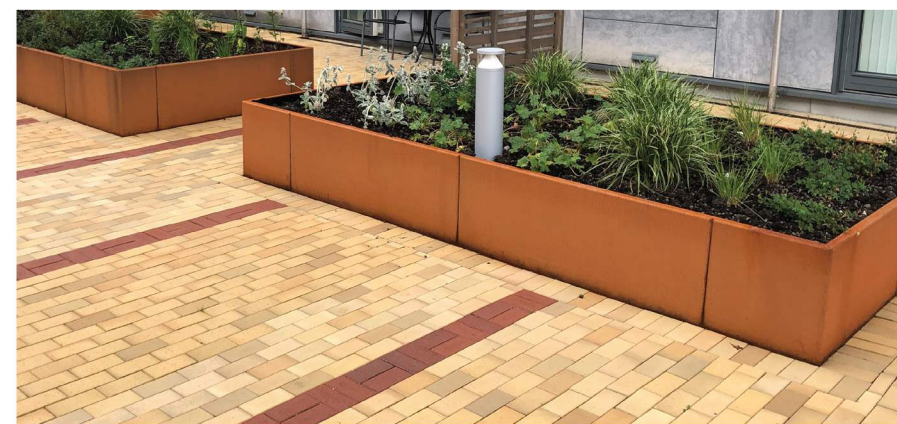
Fig.1: Marktegl og plantekasser av cortenstål Damsgårdssundet, Bergen
