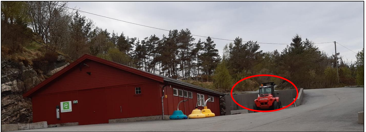
Figur 1-6. Området for planlagt ny garasje/lagerbygg vist med rød ellipse.
