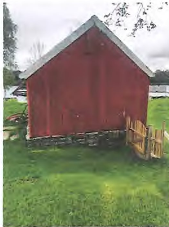
Eksisterende fasade SV
