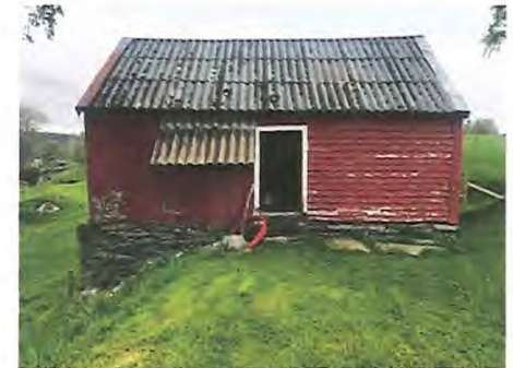
Eksisterende fasade NV
