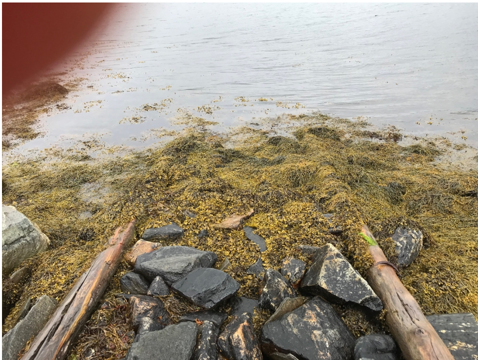
Bilde nr. 3. 4 stk.rør (slanger) ligger tvers over enden av slippen og er til hinder ved utsetting/opptrekk av båt.
