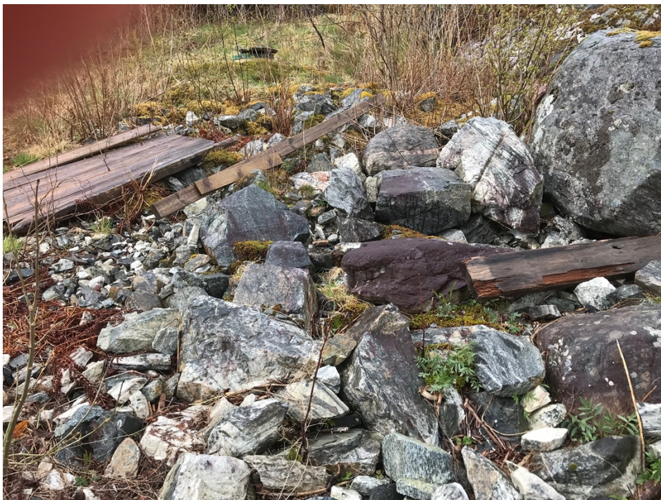
Bilde nr,2, Det er brukt store steiner til å dekke over grøft uten forsøk på å minske inngrepet eller jevne til område. (Grisearbeid)
