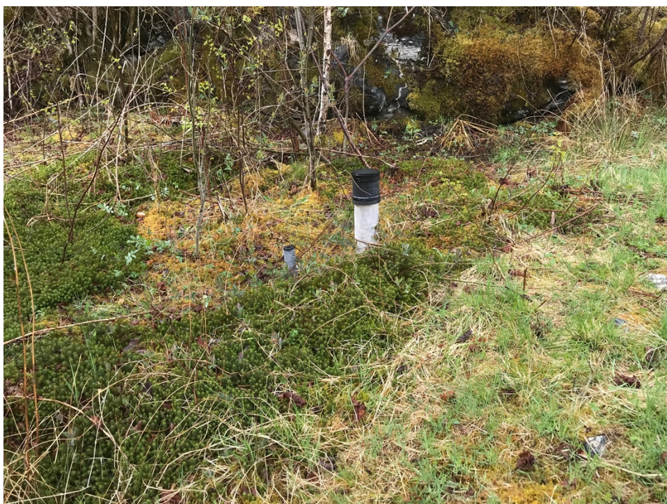
Bilde nr. 6. Stakerør og avstengingskran stikker opp og gjær tilkomst til område med traktor svært vanskelig.
