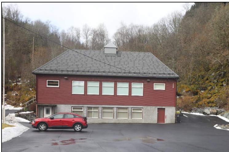
Fig. 22. Til høyre for ungdomshuset i Grasdalen er det allereie et VA-anlegg, se også Fig. 5. 20. mars 2023. Foto: A. Håland.
