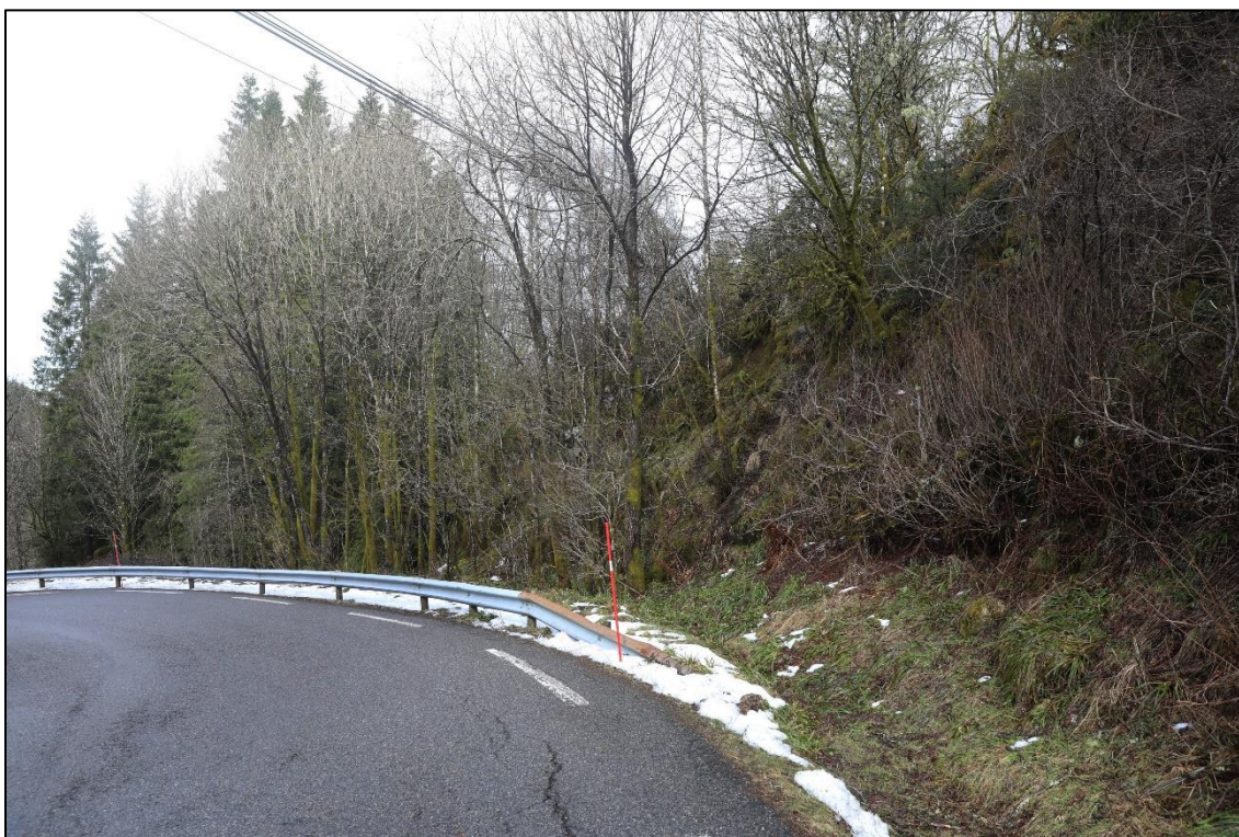
Fig. 25. Avsnitt der VA-trasé vil ha overgang frå tunell til utsprengd grøft, langs Melandsvegen. 20. mars 2023.
