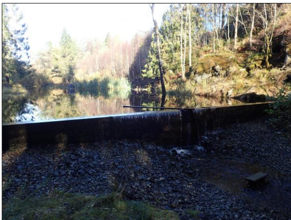
Figur 9. Fangdammer/sedimenteringsbasseng i bekken mellom Mjåtveit næringspark og Mjåtveitelva.
