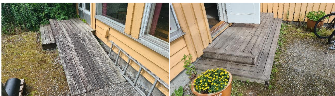
Bilde 6 – Ringmur i betong, rampe i trykkimpregnert trevirke.
