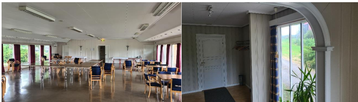
Bilde 1 – Gulvbelegget i salen inneholder asbest.
