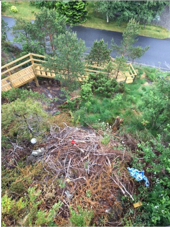
Etablert trapp til nedre del av eidegom
