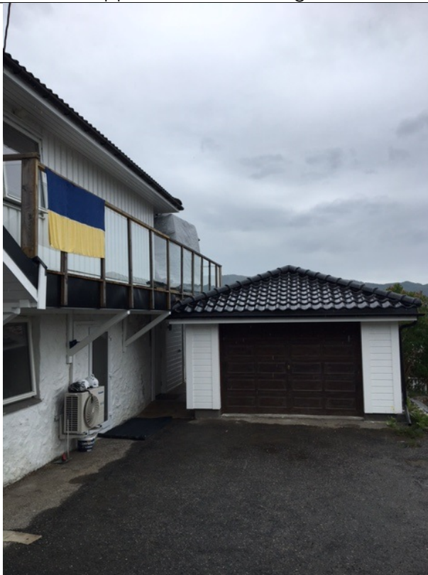
Garasje og fasade mot vest
