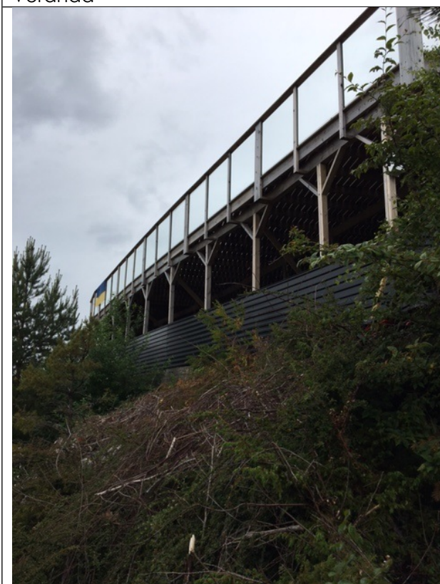
Terrasse sett nedanfrå
