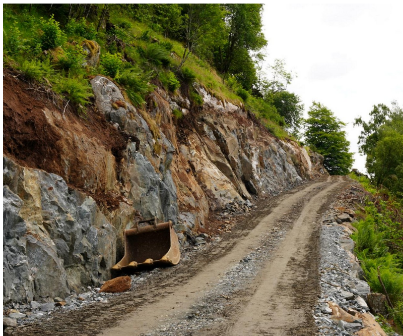
Fig 2. Under arbeid. Før fjellsikring, toppdekke og sikring av vegbane og fjell samt grøft.
