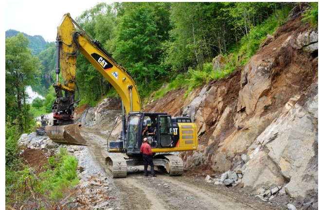
Fig 4. Under utbetring. Geolog Øivind Eikefet har vore med på prosjektet.
