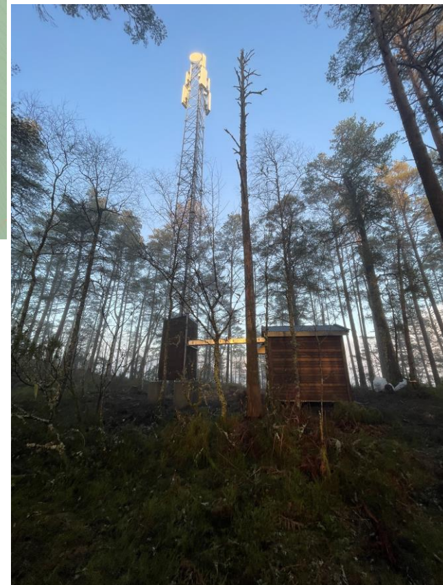
Bilde av tiltaket
