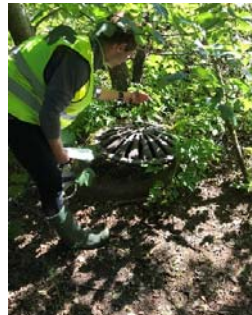
Bilde: Innløp av eks. stikkrenne
