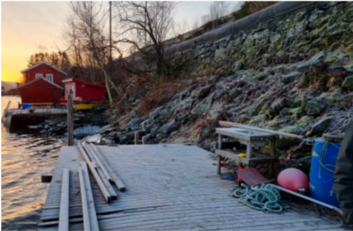
Foto av dagens situasjon, lagt ved klagen
