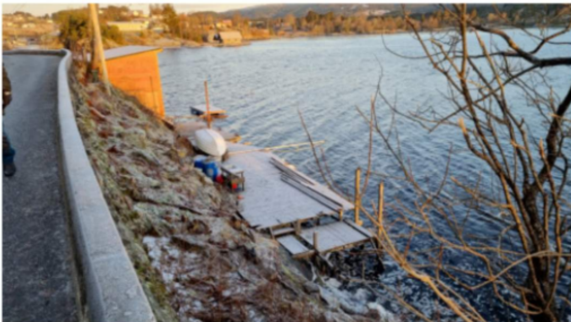
Foto av dagens situasjon, lagt ved klagen
