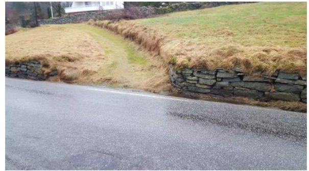
Figur 3-12: Bilde er tatt mot nord. Viser muravslutninger mot tilkomstvei.
