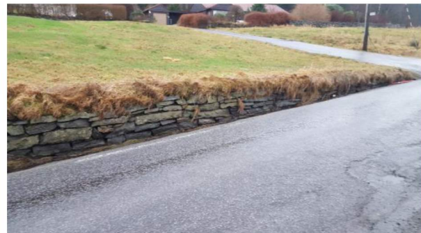
Figur 3-14: Viser resterende del av mur og endeavslutning mot synkende veipel nr.
