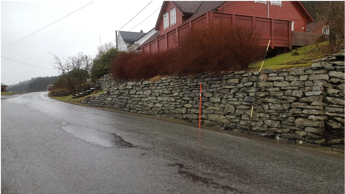
Figur 3-2: Bildet er tatt i nordvestlig retning mot stigende veipel nr. langs fv. 244. Viser deler av mur som ligger fundamentert ved veiskulder.
