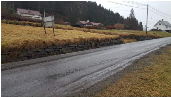
Figur 3-11: Bilde tatt mot nordøst. Viser midtre del av mur mot avslutning mot tilkomstvei.
