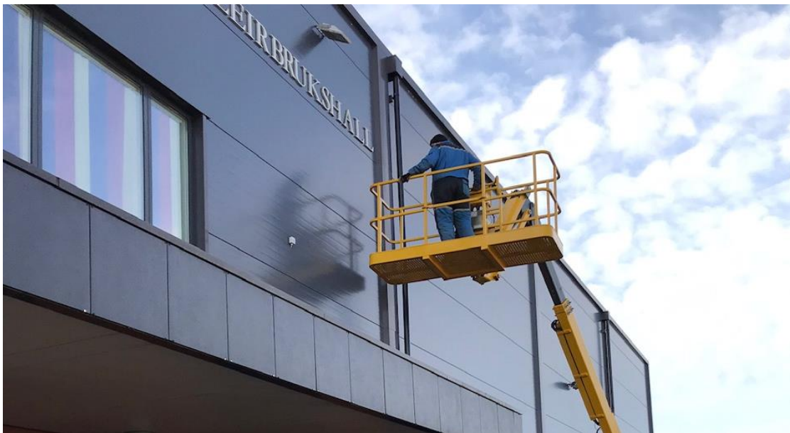
Finpuss av fleirbrukshall
