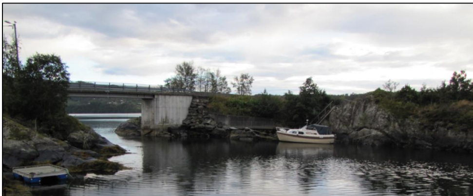
Figur 16: Bru mellom Valdaholmen (til venstre) og Grønholmen (til høgre).
