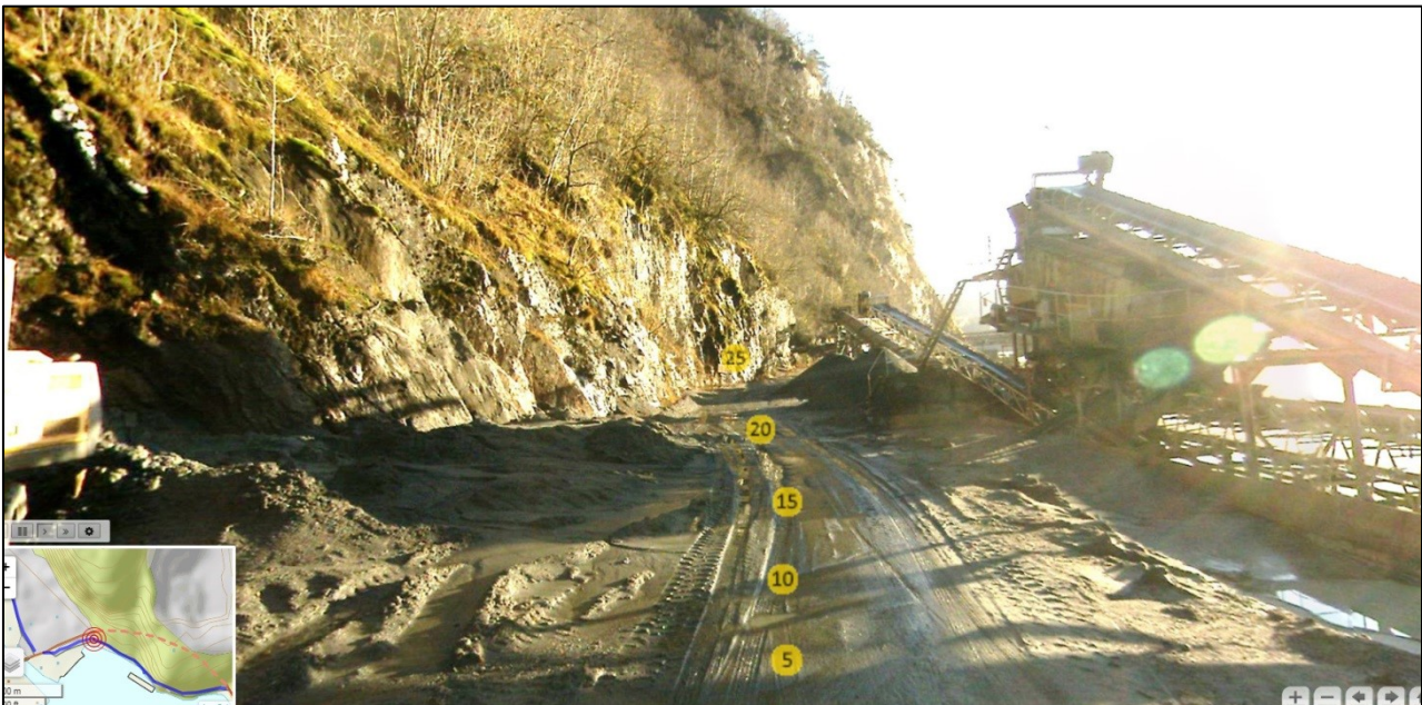
Figur 1 Gang- og sykkelvegen sett mot sør-aust
