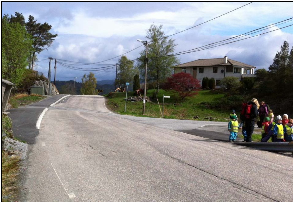
Figur 6.12. Fortau langs FV 391. Øvst til høgre: fortau midtre del. Øvst til venstre: fortau nordre del. Nedst: fortau ved skolen i sør.
