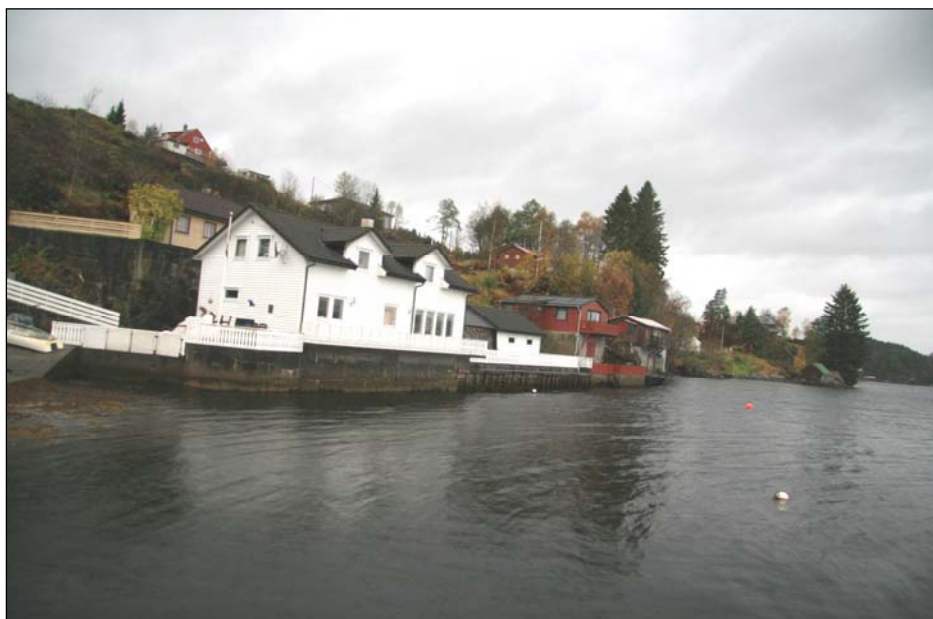
Figur 6.4. Eksisterande bygningar søraust i planområdet.
