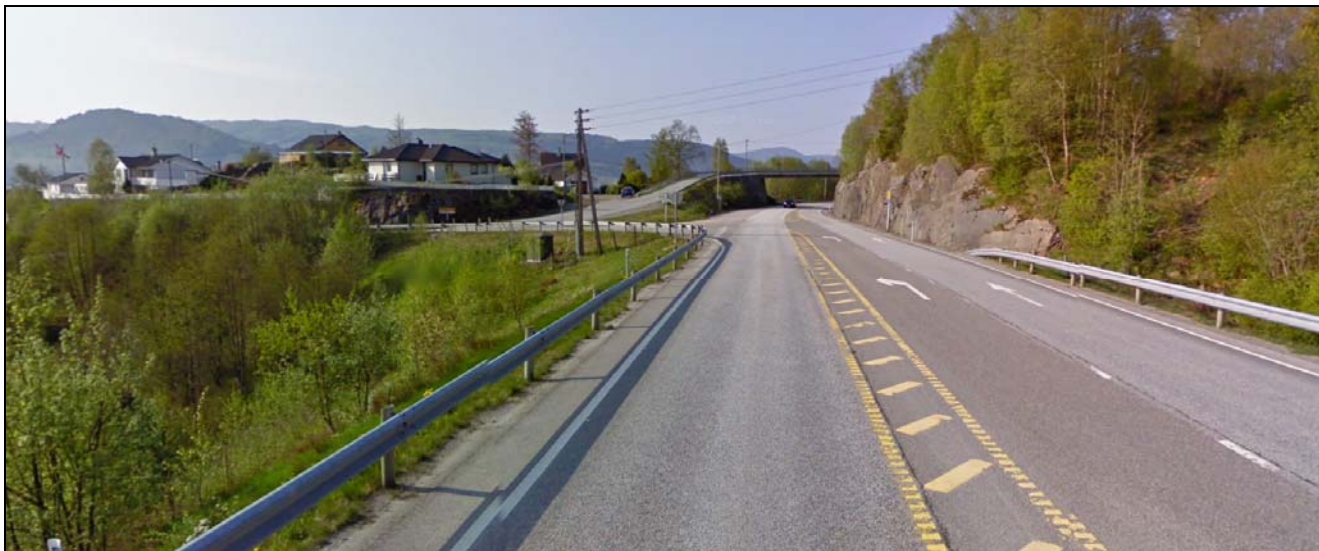
Figur 6.14. Krysset ved Mundal, sør for planområdet, mellom FV391 og E39/Osterfjordvegen.
