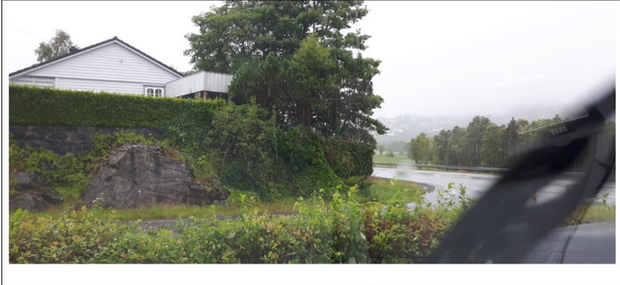
Foto som viser nivåskilnaden - ca 2m mellom vegkrysset og det asfalterte arealet ved eksisterende carport
