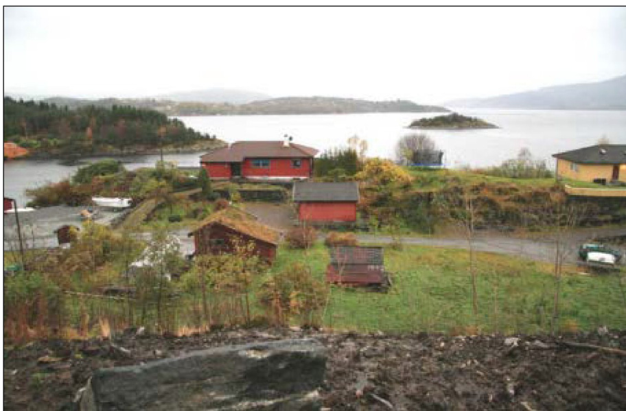
Figur 6.3. Eksisterande bygningsmasse lengst nordaust i planområdet.
