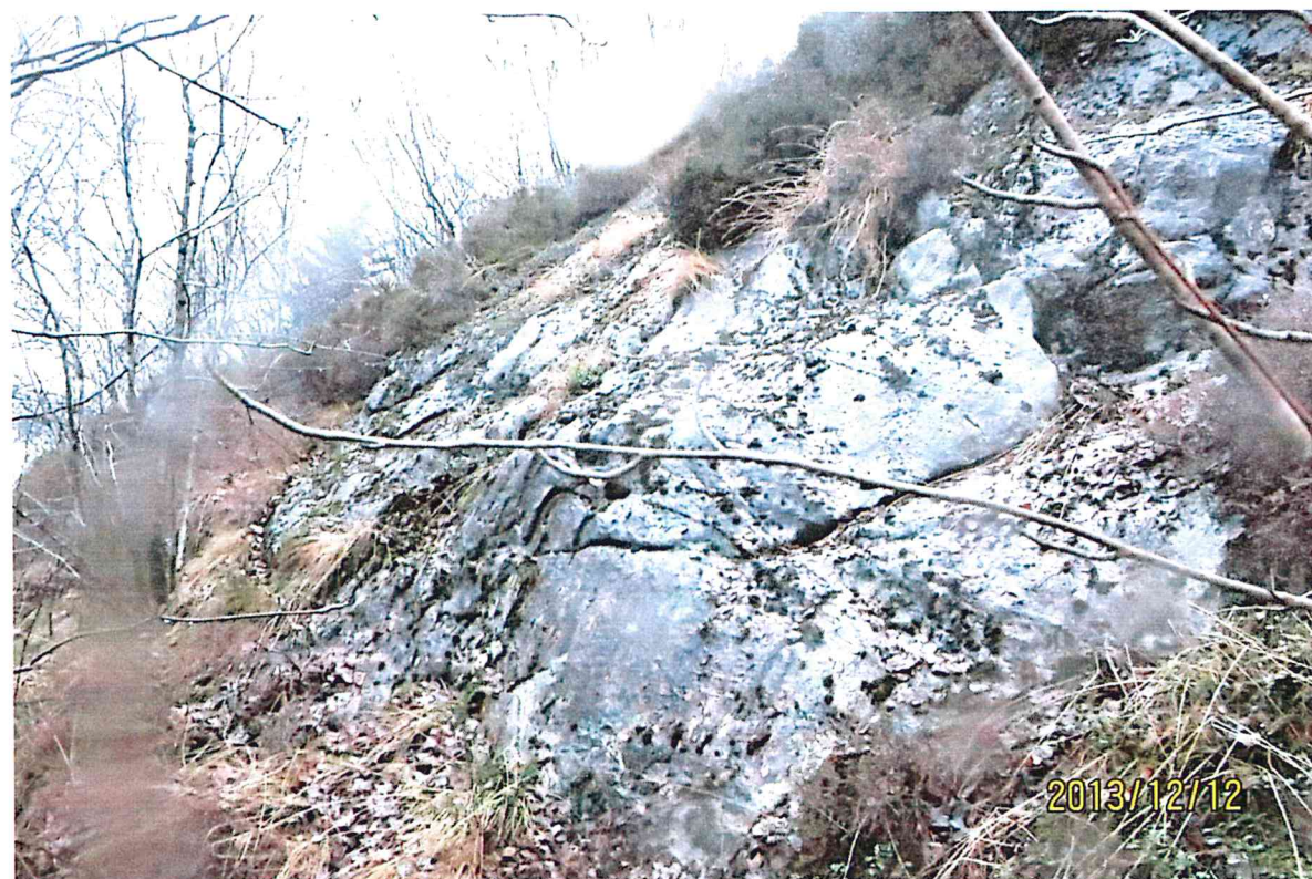
Figur 7. Blotlagt berg mot toppen av kollen. Bergoverflaten er avrundet og avrundet av isbrevaktivitet under forrige istid. Det er svært lite løst berg på bergoverflaten.
