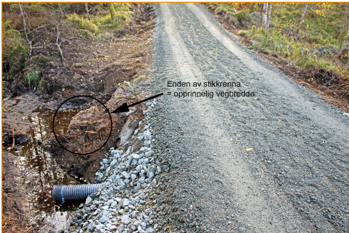
Den gamle postvegstikkrenna viser at vegen har vært ca 4 meter bred. Foto: JA 15/10 2016.
