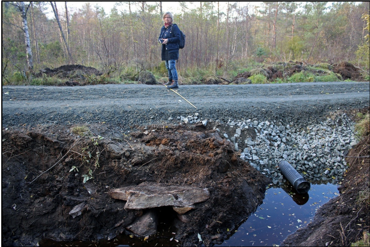
Den nye vegbredden måles til ca 2,5 m, mot rundt 4 m i resten av området. Hele vegbanen er gravd opp for å legge inn et nytt plastrør som stikkrenne – til tross for at den gamle ligger rett ved siden av. Foto: JA 15/10 2016.
