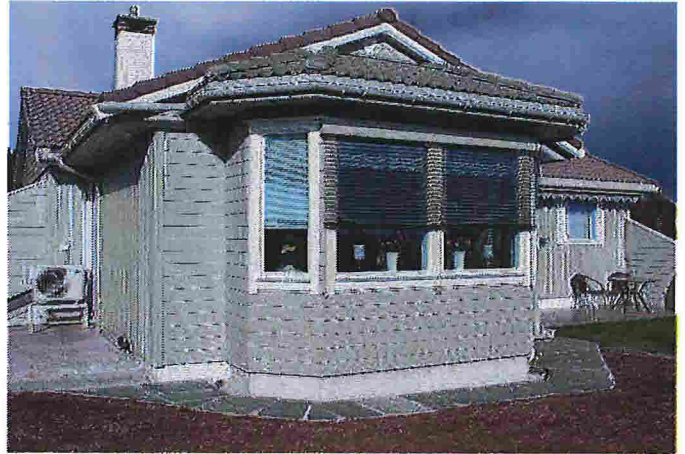
Karnapp ferdig – sett får ca. vest
