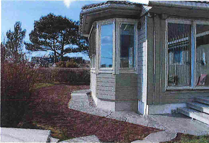
Karnapp – ferdig. Sett frå ca sør.
