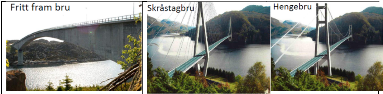
Bilde: De 3 ulike brotypene som er vurdert for kryssingen av Landsvikosen.
