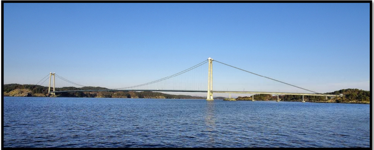
Bilde: «StordBridge» av Henke. - Stord Bridge (Stordabruo).
