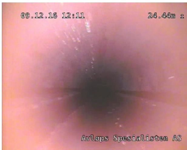
Foto: 24.44.jpg 24.44m, Vannivå 0%.
