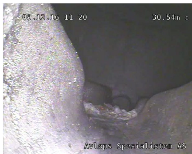
Foto: 31.00.jpg 30.54m, Vannivå 0%. Inspeksjon avsluttet i Kum Eks SP
