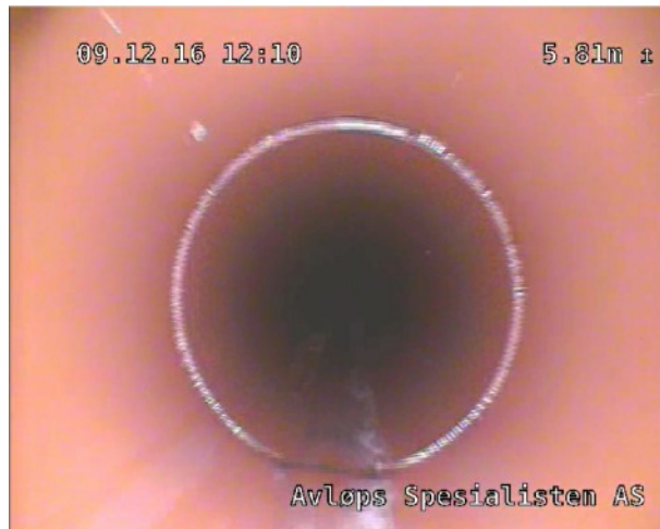
Foto: 5.81.jpg 5.81m, Vannivå 0%.
