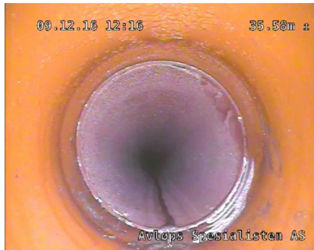
Foto: 35.58.jpg 35.58m, Vannivå 0%. ME Matrialending Plast, DE Dimensjons endring
