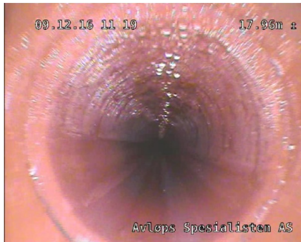
Foto: 17.96.jpg 17.96m, Vannivå 0%.
