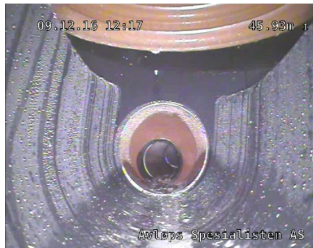
Foto: 45.93.jpg 45.93m, Vannivå 0%. Inspeksjon avsluttet i Kum S6 mini
