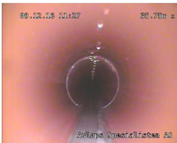
Foto: 35.75.jpg 35.75m, Vannivå 0%.
