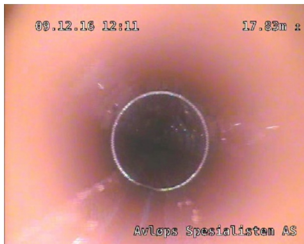
Foto: 17.83.jpg 17.83m, Vannivå 0%.
