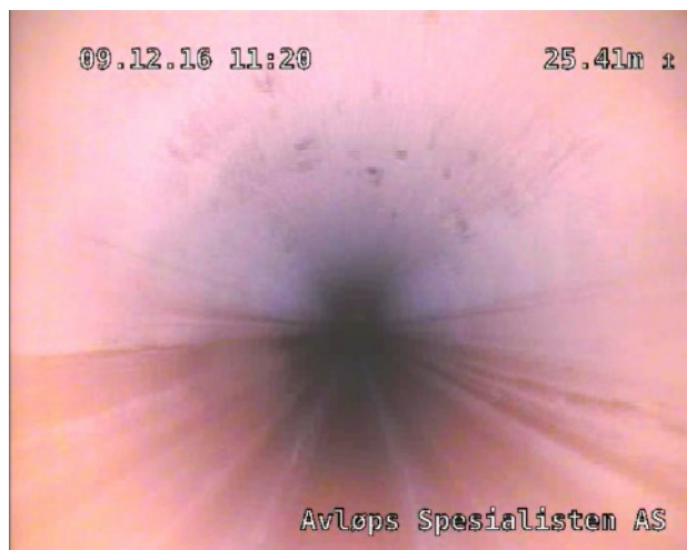
Foto: 25.41.jpg 25.41m, Vannivå 0%.
