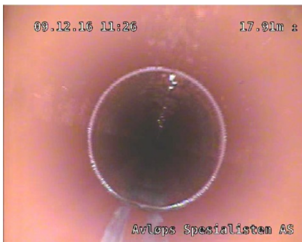
Foto: 17.91.jpg 17.91m, Vannivå 0%.
