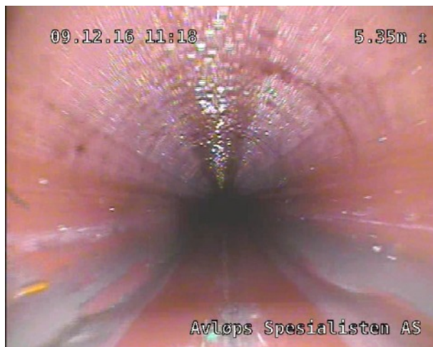
Foto: 5.35.jpg 5.35m, Vannivå 5%.
