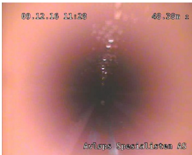
Foto: 48.38.jpg 48.38m, Vannivå 0%.
