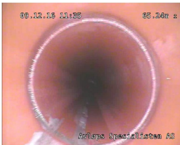
Foto: 65.24.jpg 65.24m, Vannivå 0%.
