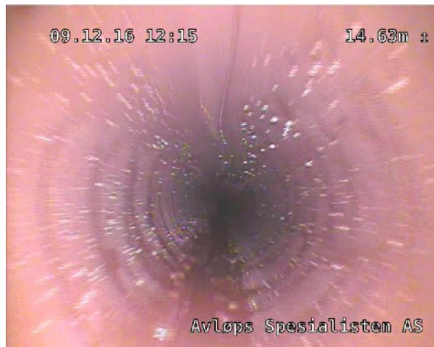
Foto: 14.63.jpg 14.63m, Vannivå 5%.
