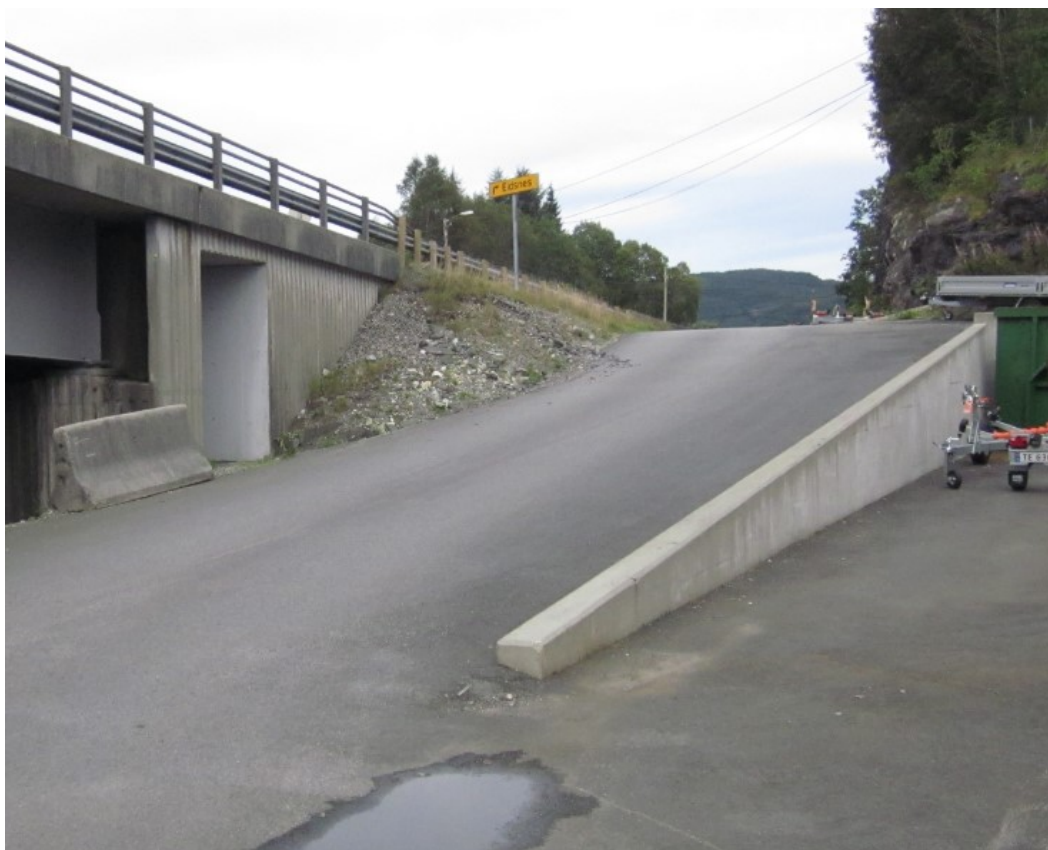
Foto: Undergang til E39.
