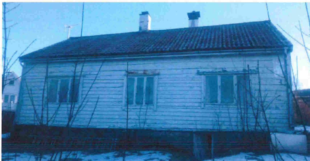
Eksisterende våningshus på bnr. 4, som skal rives
