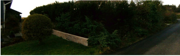
Mot nord - mur mellom gbnr. 108/153 og 108/129
