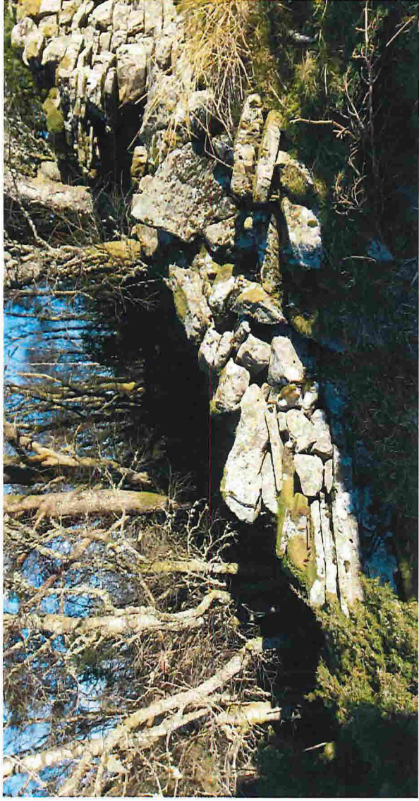
Reparasjon av steingard
