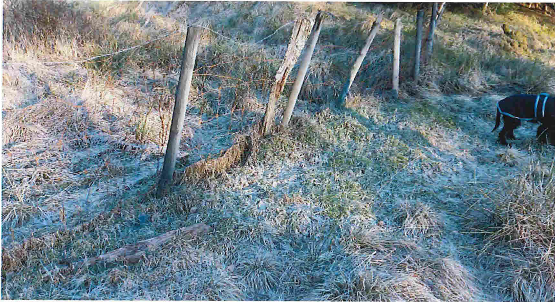
Rydding og montering av nytt gjerde.
