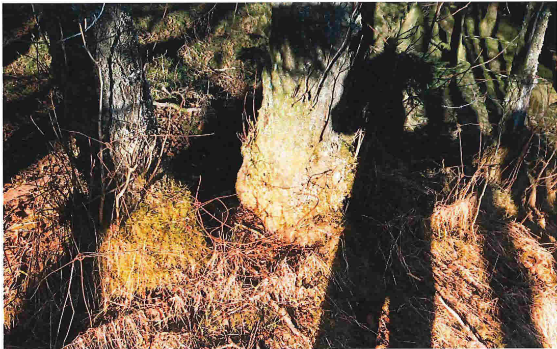
Rydding og montering av nytt gjerde.
