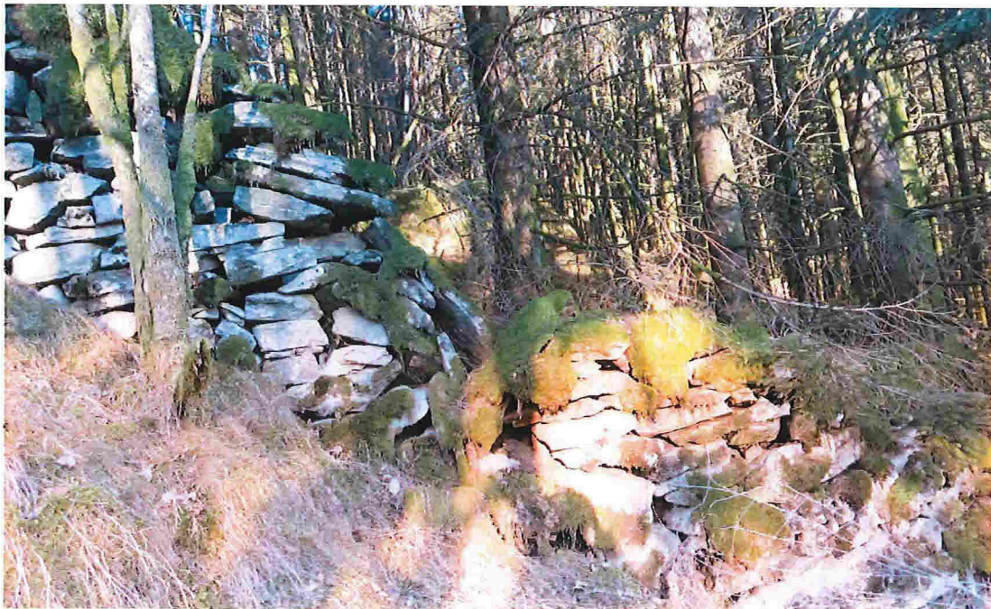
Reparasjon av steingard.
