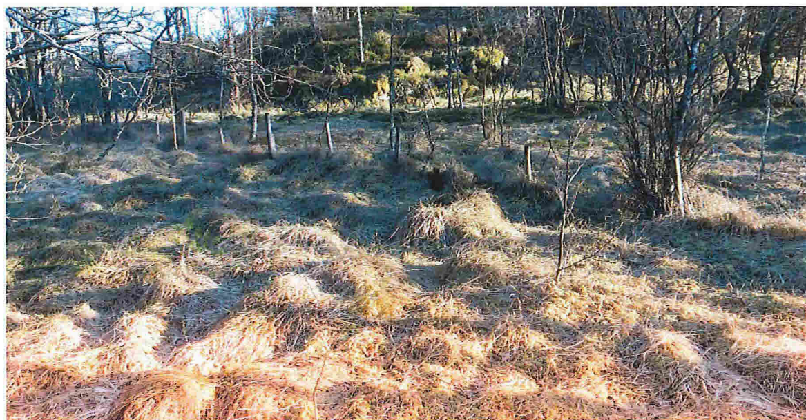
Rydding og montering av nytt gjerde.
