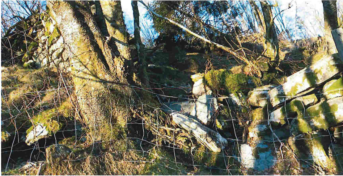
Reparasjon av steingard
