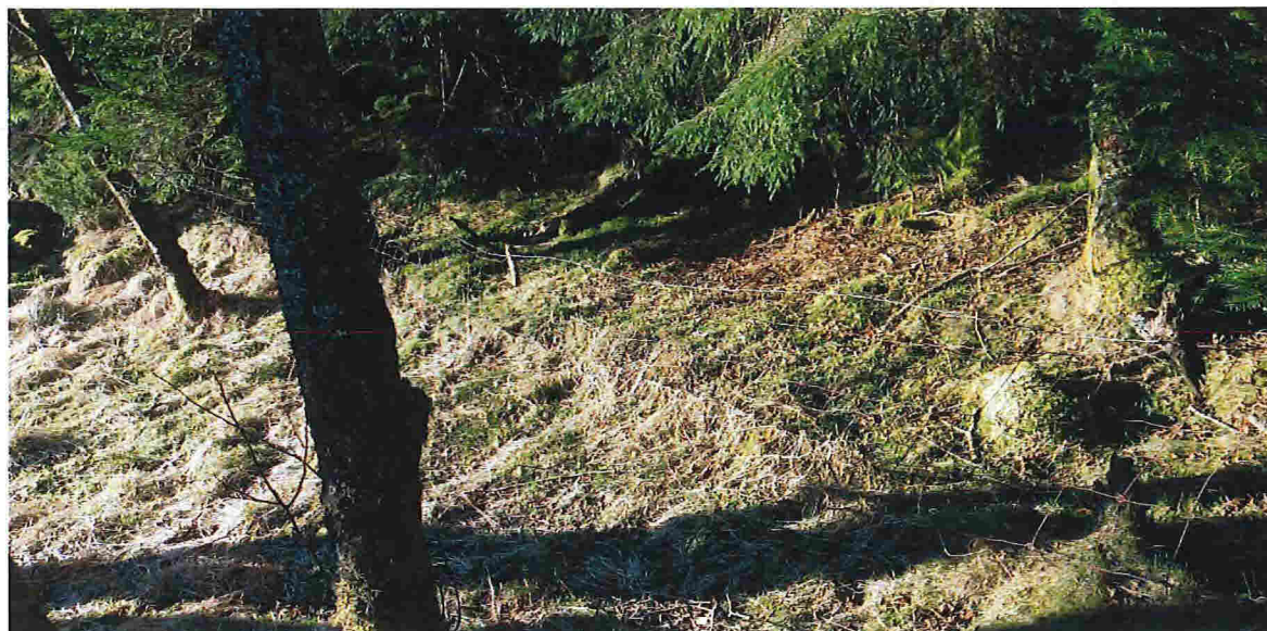
Rydding og montering av nytt gjerde.
