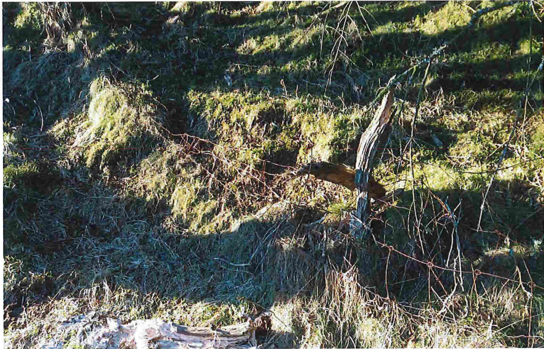
Rydding og montering av nytt gjerde.
