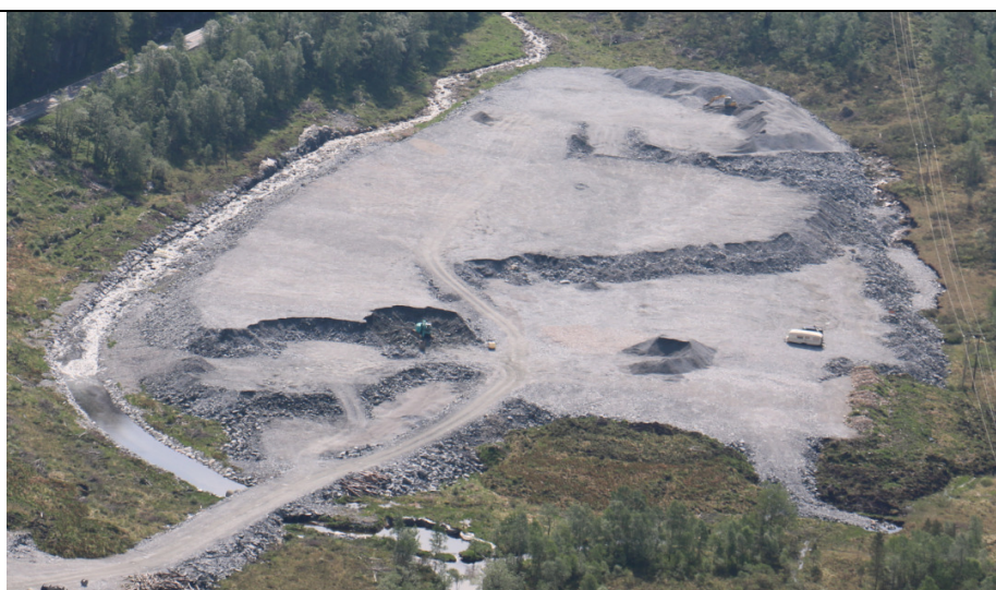
Steindeponi i Haugsværdalen. Riggplass etableres på fremre delen av deponiet.
