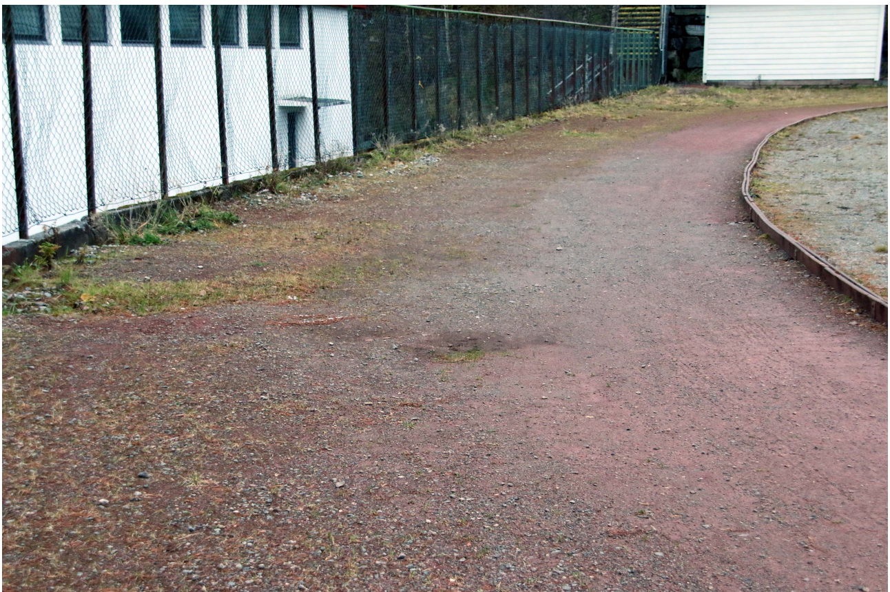
I vestre sving mot idrettsbygget manglar det mykje raudstubb.
