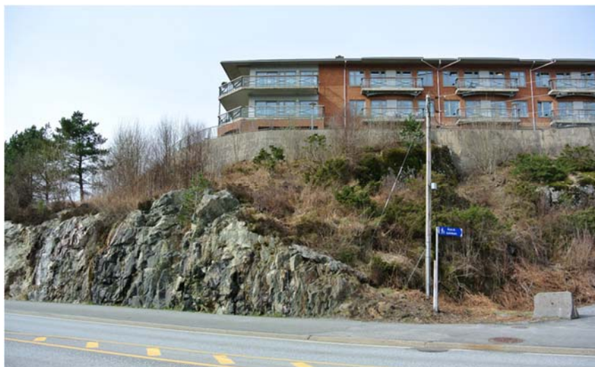
Bilde tatt mot Knarvik sjukeheim viser eksisterande bergskjering og terreng opp mot støttemur. Bildet viser høgaste punkt på eksisterande skjering.
