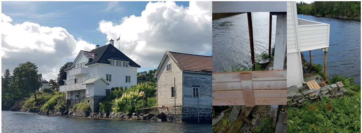
Kai for større båtar i tilknytning til grunnmur og veranda på hovudhuset.
