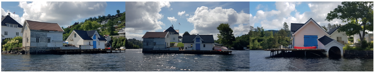
Tre meter brei terrasse rundt sjøhus mot nord.
