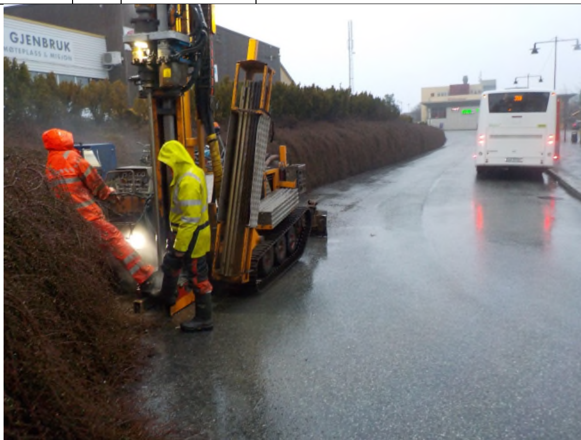
Oversiktsbilde fra prøvetaking ved punkt 17 og 18 på bussterminalen i Knarvik sentrum.
