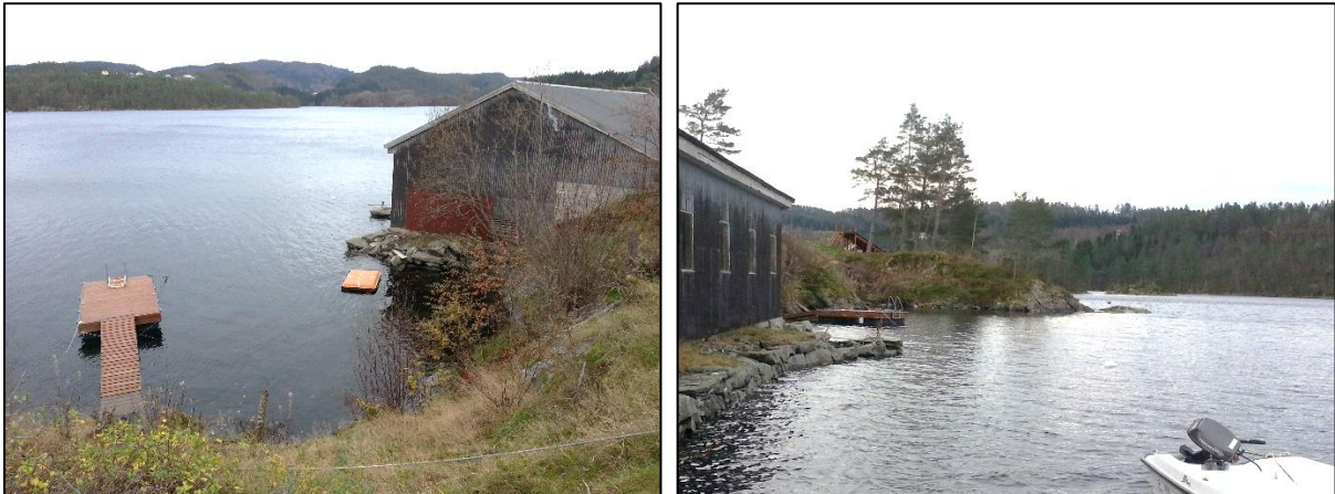
Figur 13: Badebrygga sør i planområdet. Det svarte bygget er Åsgard 31.
