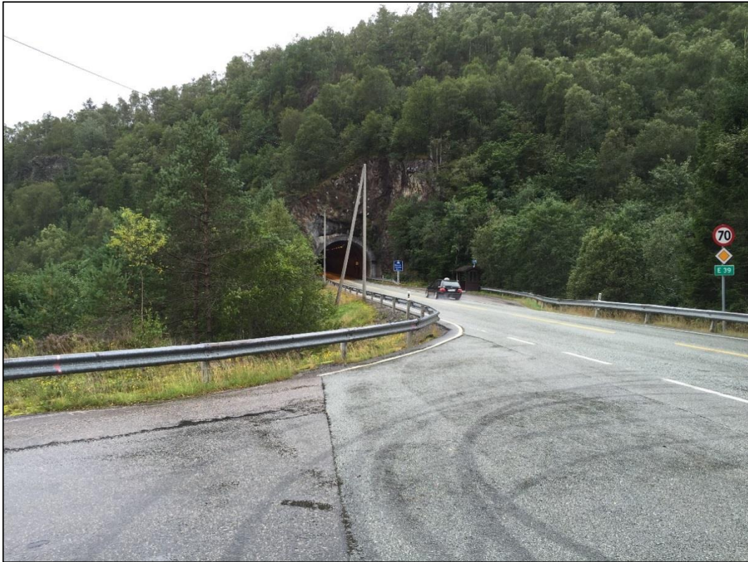
Figur 3 – Bjørsvikkrysset, E 39 og nordre tunnelportal Bjørsviktunnelen
