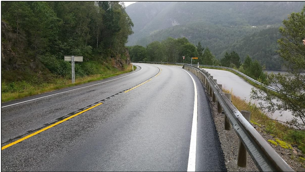
Figur 2 – Molvikkrysset, sett frå E 39
