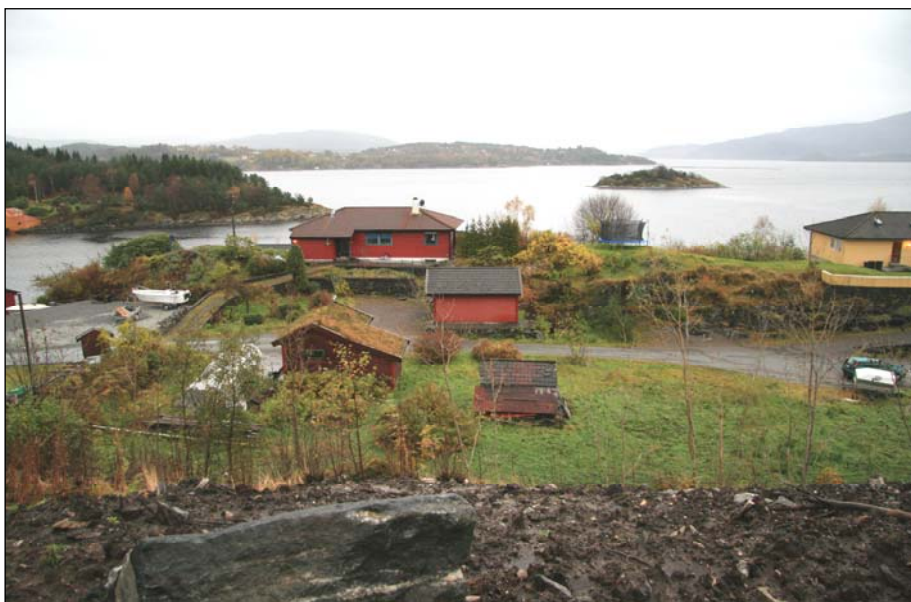
Figur 6.3. Eksisterande bygningsmasse lengst nordaust i planområdet.
