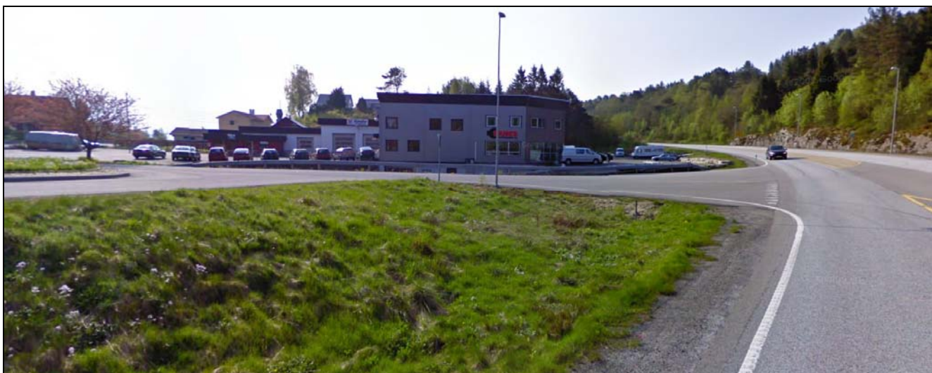
Figur 6.15. Avkjørsle frå fylkesveg 391 til E39 ved Hillesvåg.
