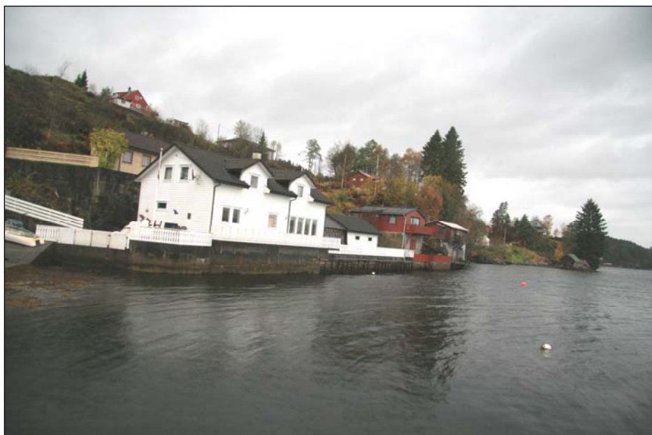
Figur 6.4. Eksisterande bygningar søraust i planområdet.
