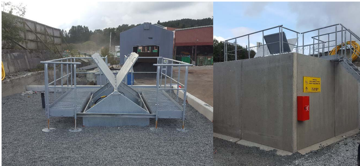
Figur 2: Eksempelbilder av tilsvarende gassforsyningsanlegg
