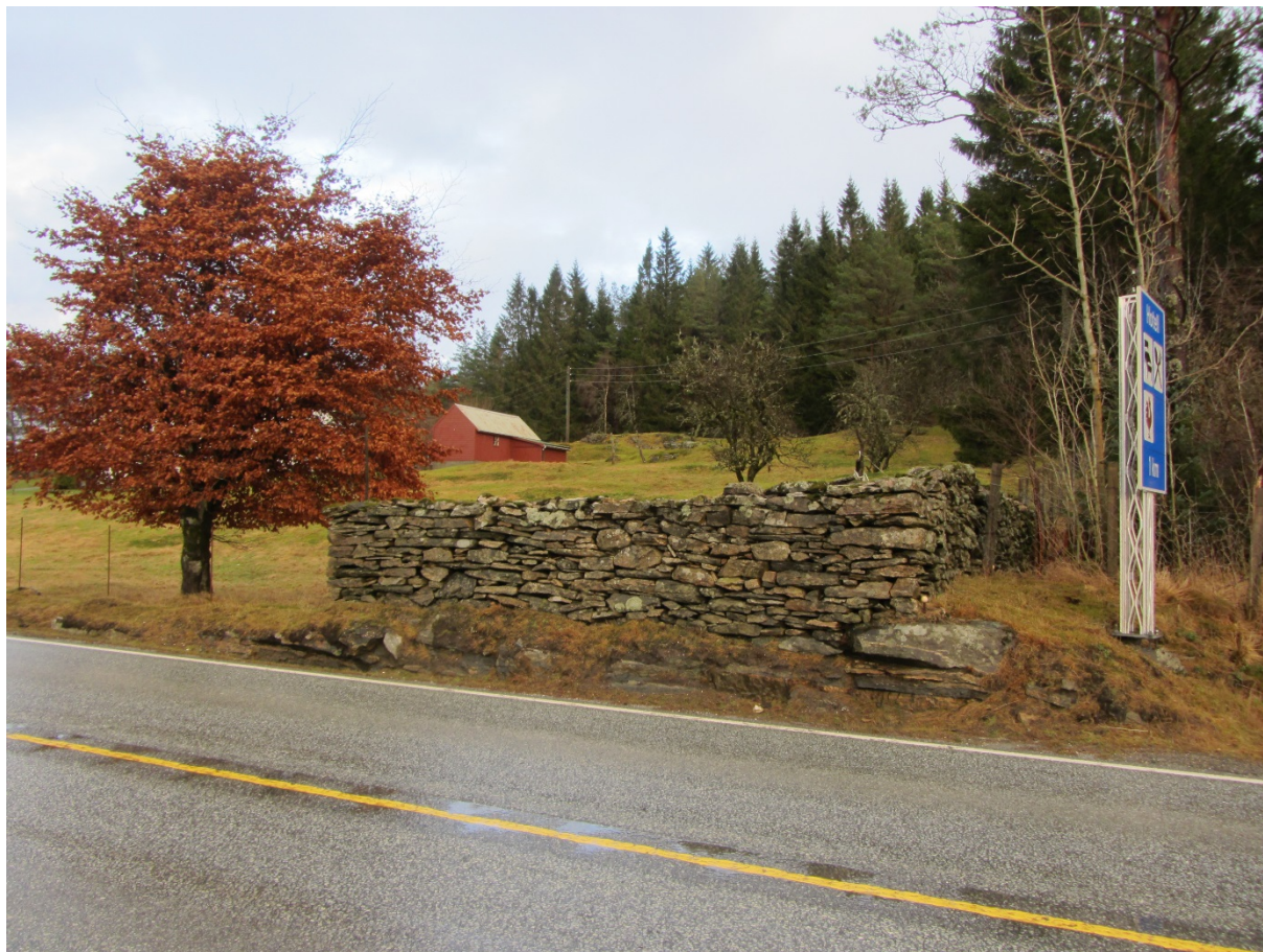
Tørrmur langs vegen på gnr./bnr. 99/7, Våge. Foto frå synfaring, fotograf Eilin Basset, Statens vegvesen
