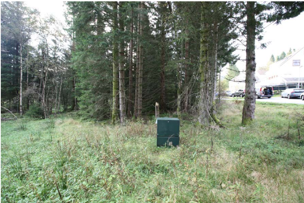
Mogeleg pumpeasjon ved Skodvin skule, Foto frå synfaring, fotograf Silje U. Lyngstad, Statens vegvesen
