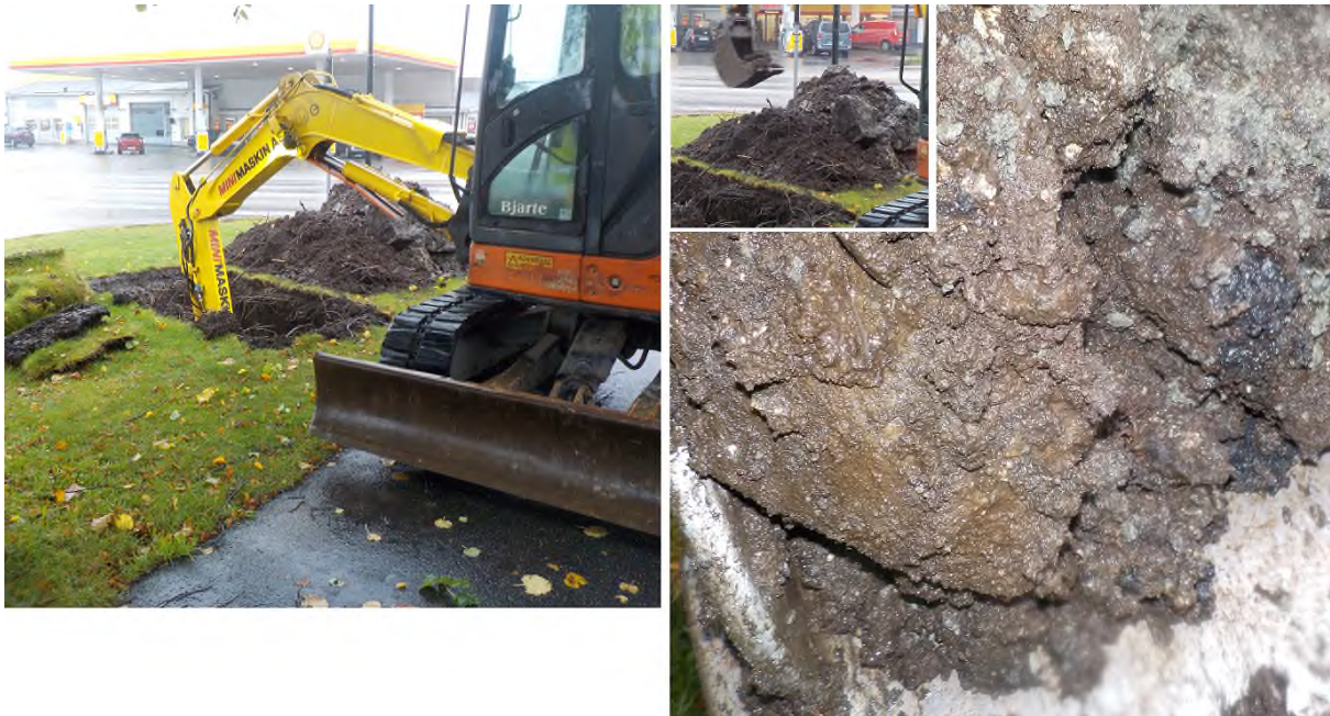
Figur 18. Bildene er tatt under sjakting i punkt 28. Sjakten ble 2,5 m dyp. Flere bilder er tilgjengelig på forespørsel.
