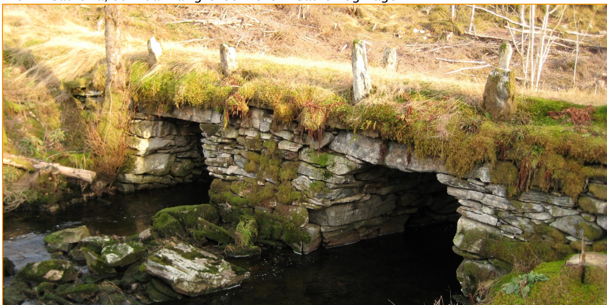
Figur 5 Postvegbrua på Gaulen. Foto Tine Eikehaug, Statens vegvesen.
