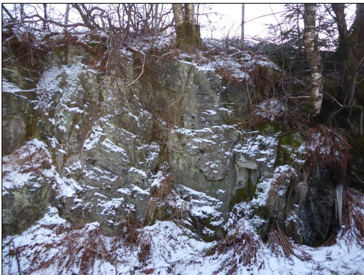
Figur 16: Bergmassen ved tenkt plassering for landkar akse 1
