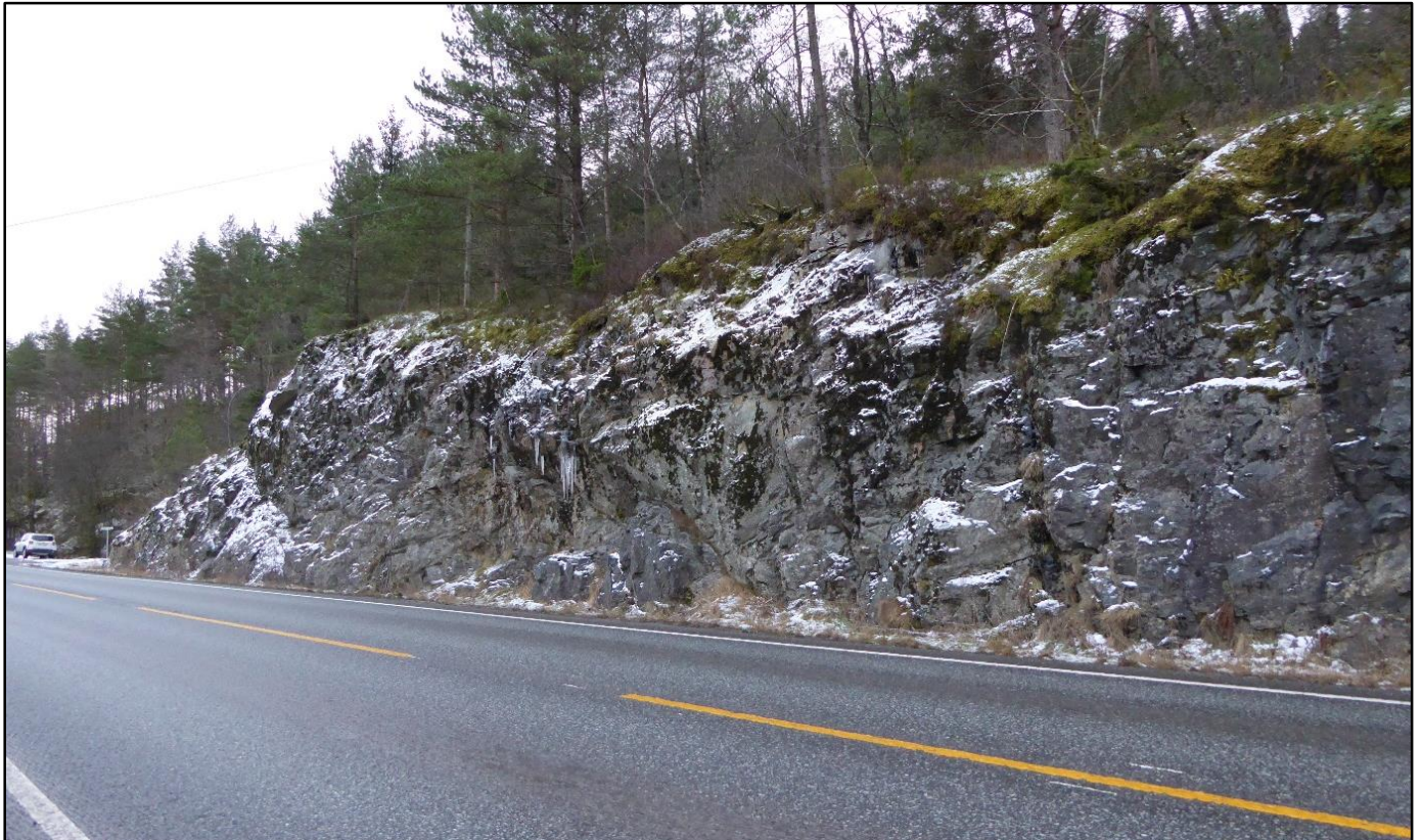
Figur 9: Eksisterende fjellskjæring mellom profil 2880 og profil 3130
