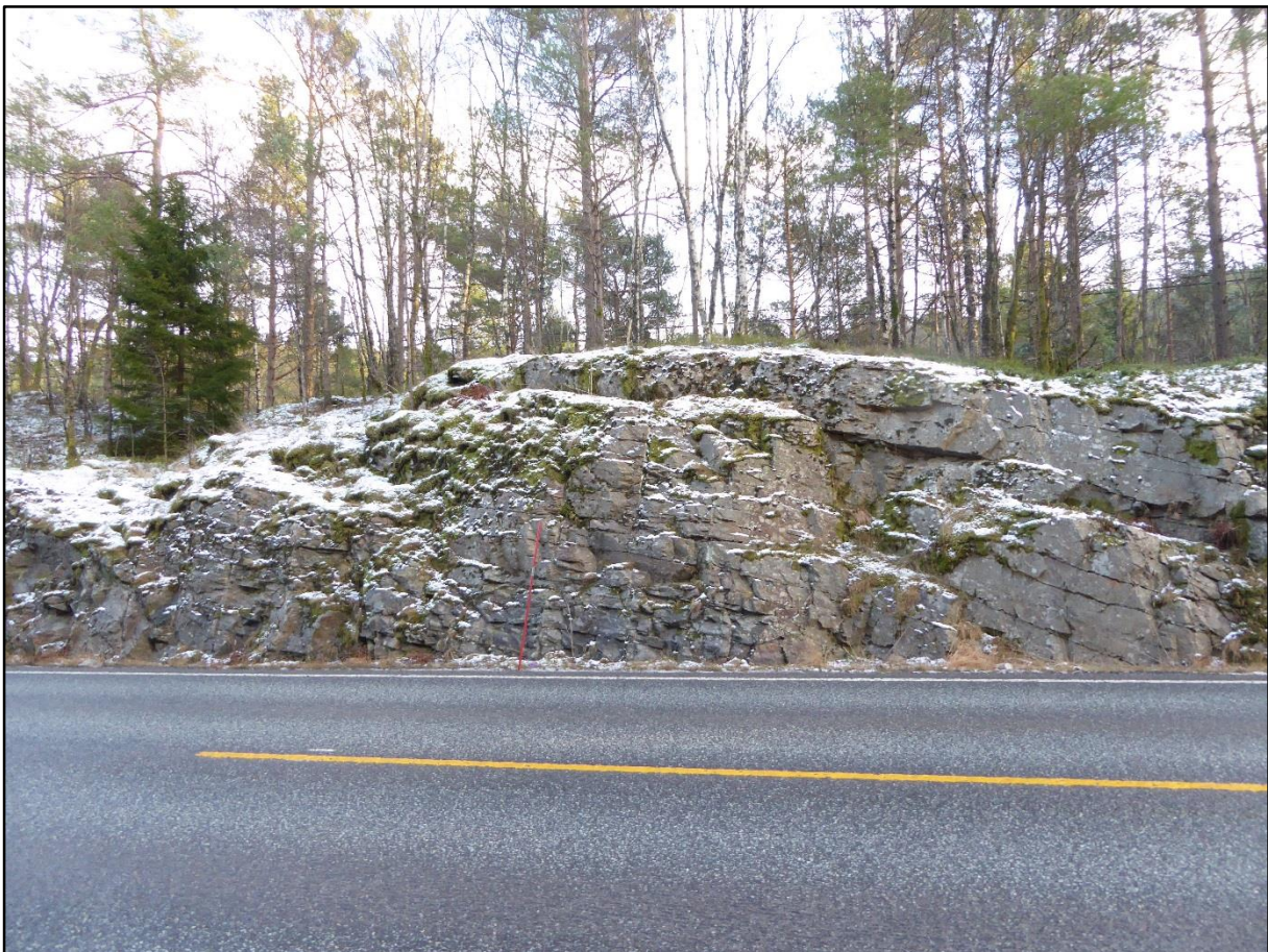
Figur 13: Eksisterende fjellskjæring mellom profil 500 og profil 530
