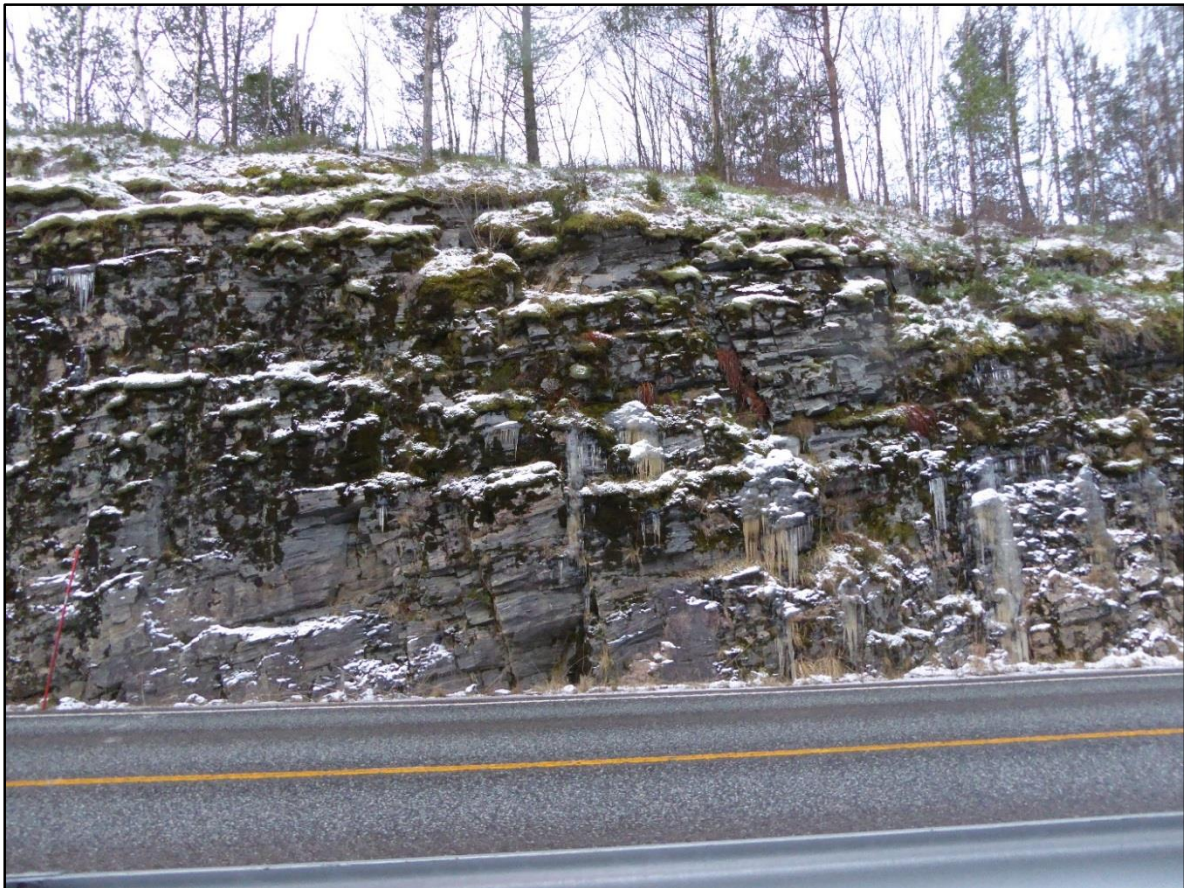
Figur 5: Eksisterende fjellskjæring mellom profil 890 og profil 1050.
