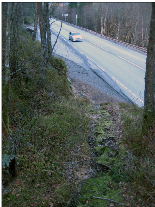
Foto 7 og 8: Fra endepunkt Strekning 1. Her er det bare en bratt sti mellom Postveien og fv.57. Foto Tine Eikehaug, SVV.
